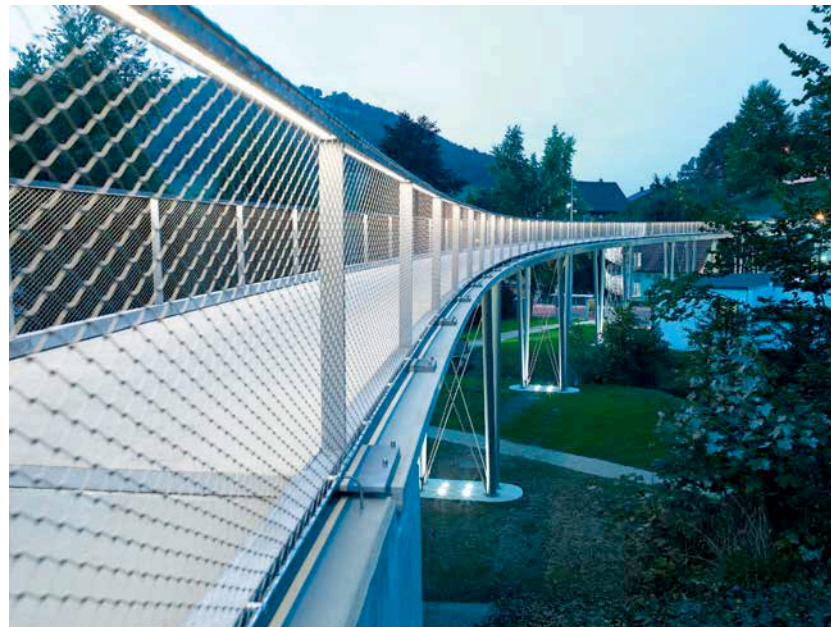
Die Textilbetonbrücke Albstadt-Lautlingen misst rund 100 Meter
